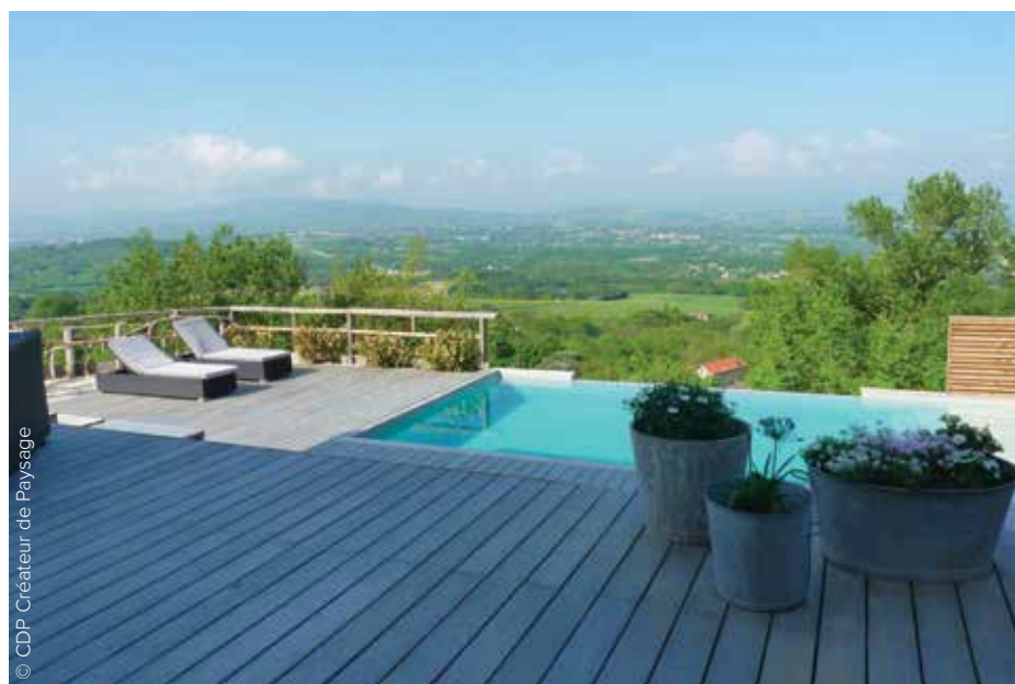
La plage de piscine est en garapa, une essence de bois provenant du Brésil, elle prend des teintes grises en vieillissant. La plage de piscine est constituée de lames de bois de 140 mm de large et 20 mm d'épaisseur, installées sur pilotis.
