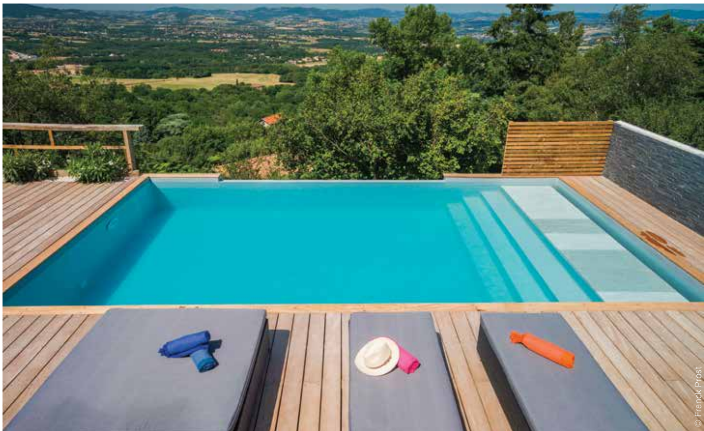
En béton, avec un revêtement en PVC armé gris clair, la piscine est de forme rectangulaire et de petit format (7,20 m x 4 m).
