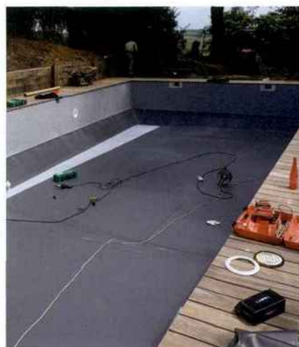
Couleur gris anthracite, le liner donne à l'eau une couleur très naturelle. Il a été installé par-dessus un feutre antibactérien.
